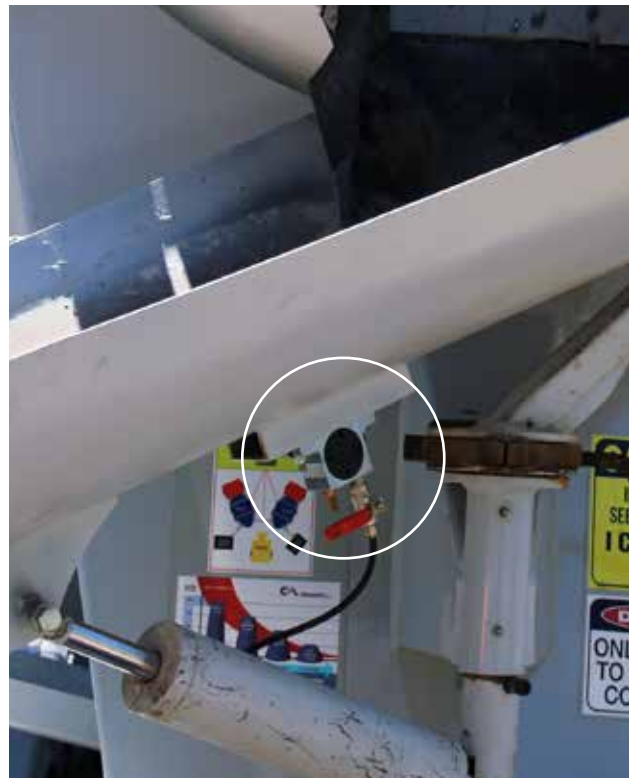
OT [Vibrador Pneumático Rotativo] - Rampa de Mistura de Concreto
